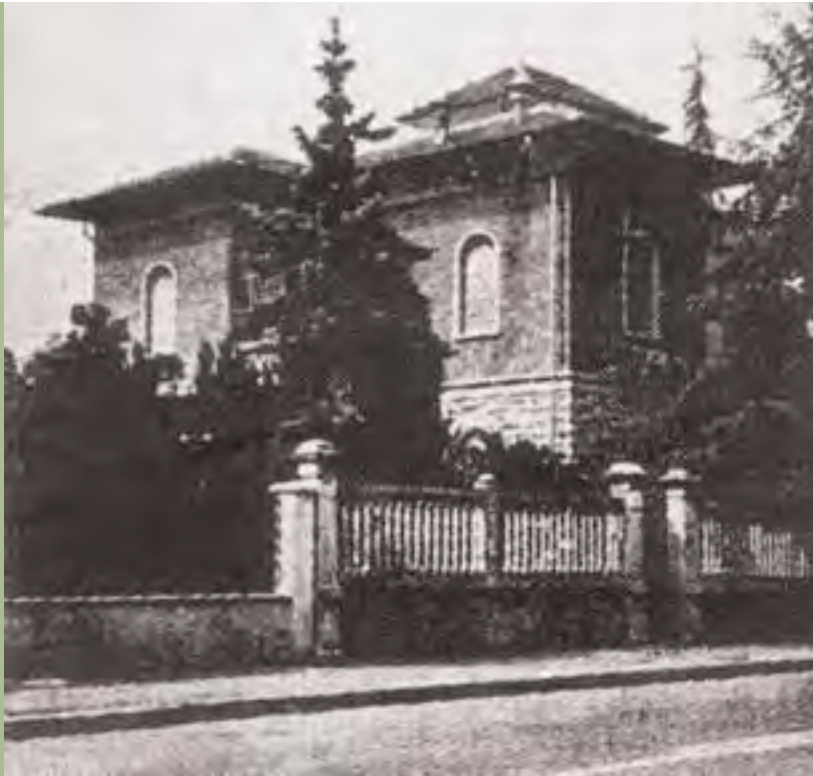
La fotografía de la Sede del “Istituto de Operarias de María Inmaculada” y el Edificio Civiltá, en calle Galileo Galilei 121 – Brescia, que fue publicada en la Revista “Chiesa viva” durante muchos años.
